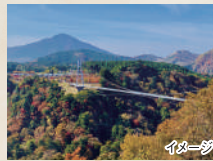
2日目 九重"夢"大吊橋
