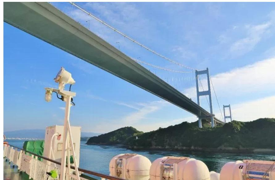
来島海峡大橋の完成は、3つの大橋の中で最も新しい1999年。世界初の三連吊橋構造で、瀬戸大橋と比べるとやや女性的でスリムな美しさを誇っているような気がします。
