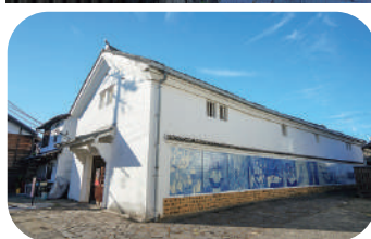
江戸時代末期に建てられた酒蔵「久家の大蔵」。外壁をボルトガルと白杵の交流を表現した装飾タイル「アズレージョ」が彩る
