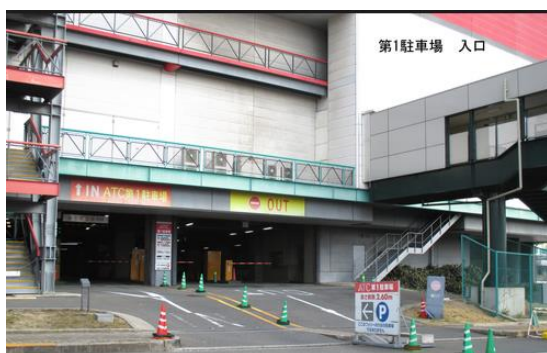
ATC第1駐車場入り口前
