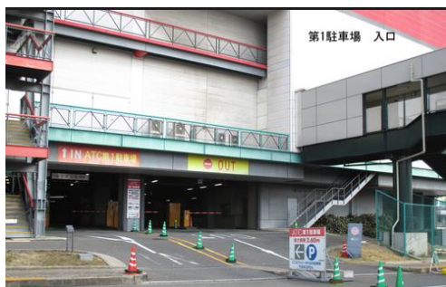
ATC第1駐車場 (ITM棟内) 入り口前
