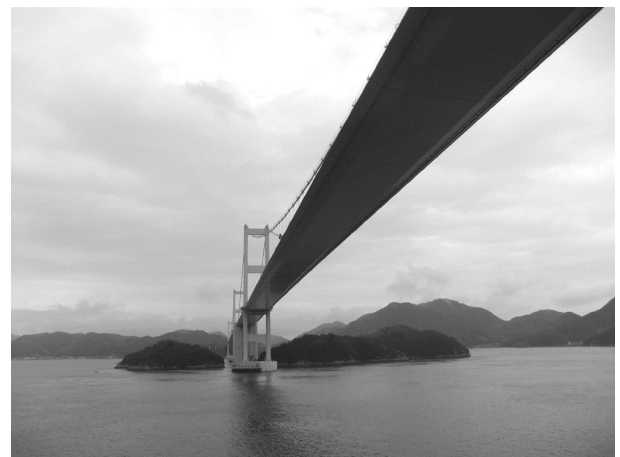
来島海峡大橋をくぐり抜ける
